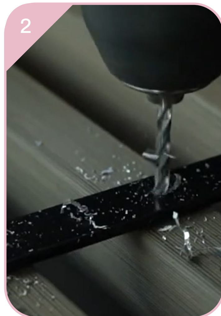
FIXAÇÃO EM BARRA CHATA METÁLICA
