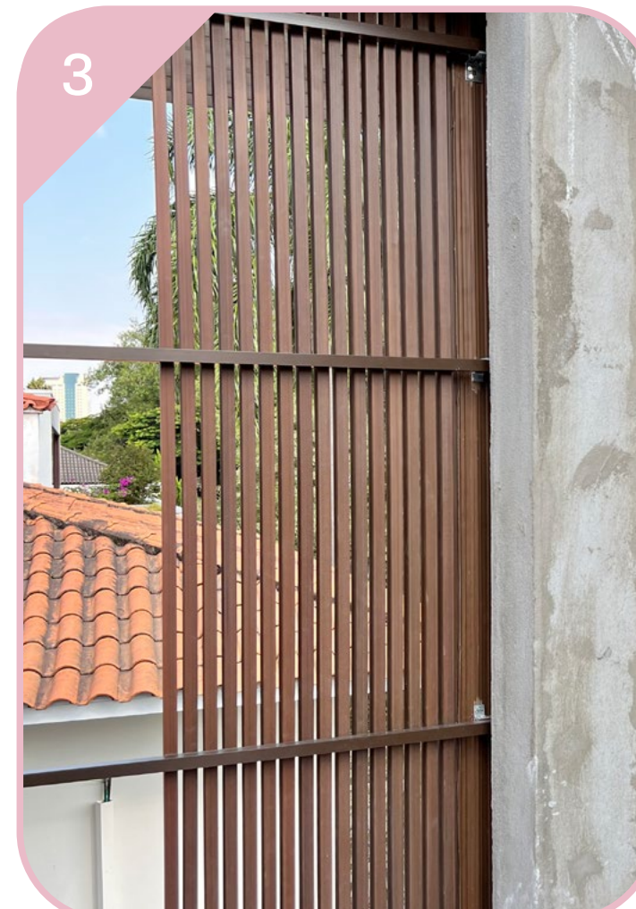
FIXAÇÃO NA ESQUADRIA / ALVENARIA
