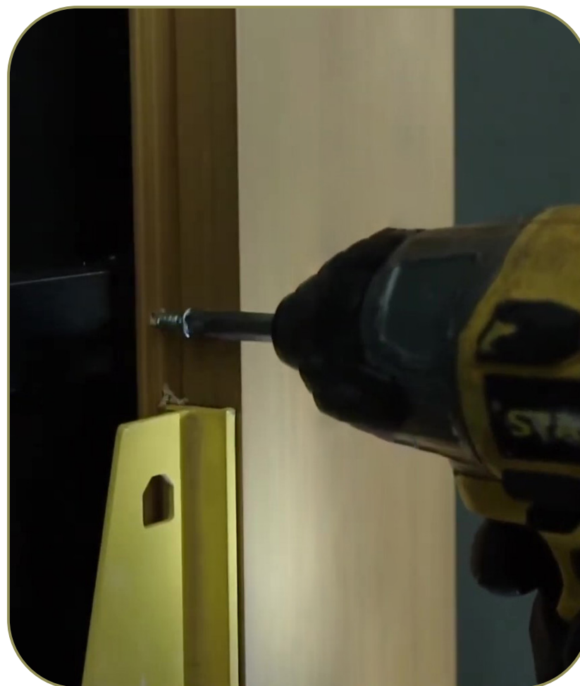
PARAFUSAÇÃO DAS CANTONEIRAS E APLICAÇÃO DOS PERFIS
