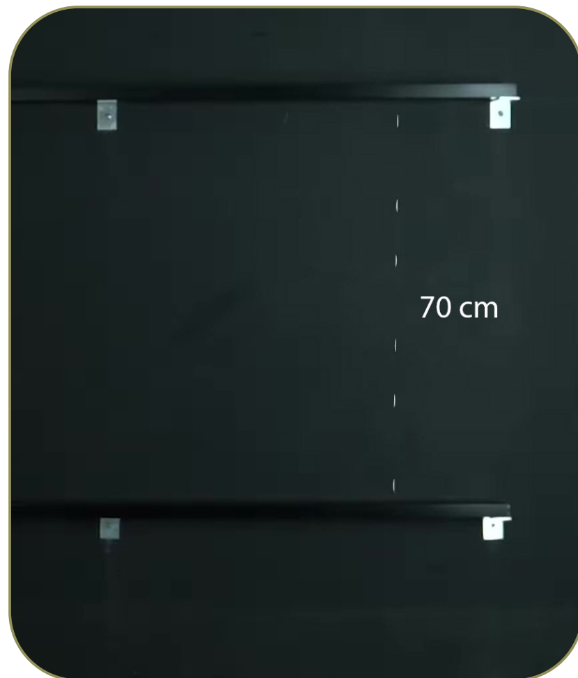
CALCULAR DISTANCIAMENTO ENTRE APOIOS
